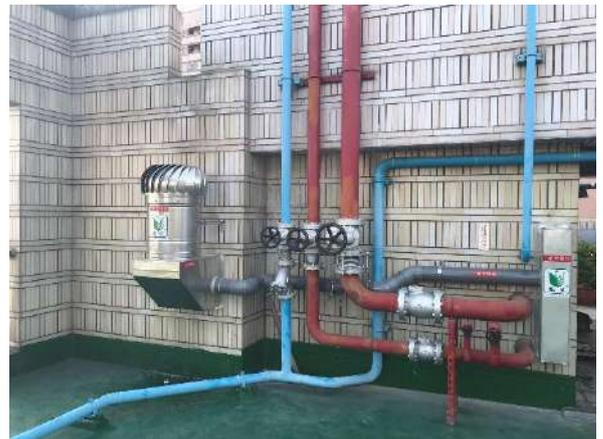
管道內安裝鵬風 20 英吋風電兩用型排風機
